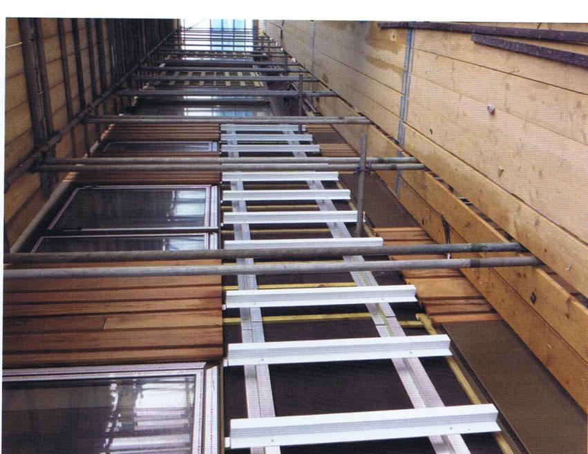
De balkons zijn uitgevoerd als een houten vlonder. De naden tussen de delen zijn ca. 5 mm, waardoor doorzicht wordt voorkomen.
